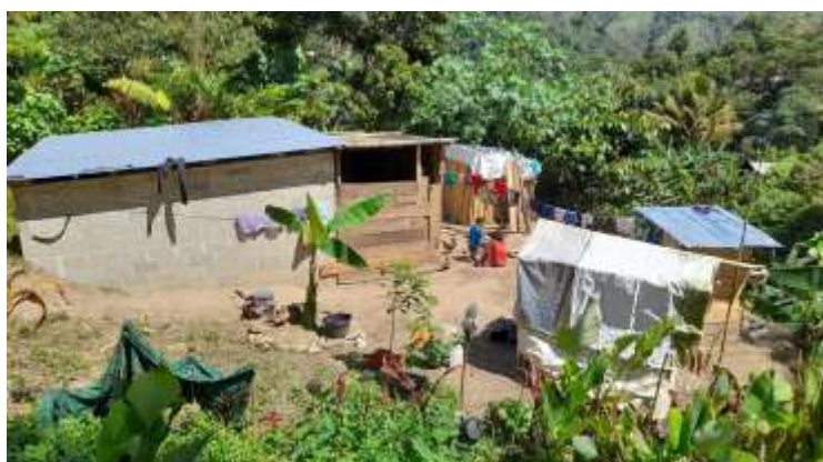
Vista general de una de las viviendas de nuestro proyecto
