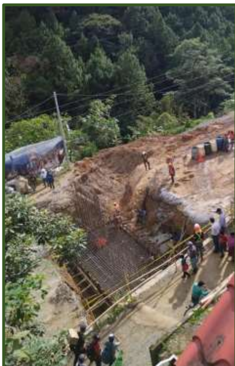
El nuevo puente, para eliminar la falla
