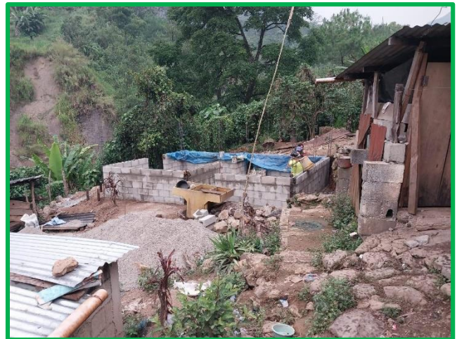
Tras allanar el terreno, se inicia la construcción
