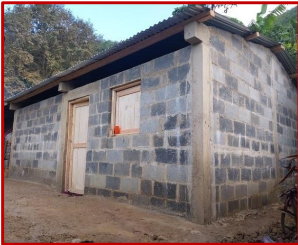
La nueva vivienda, ya finalizada
