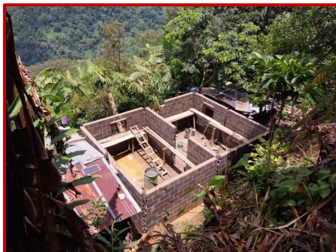
Avances en la edificación de la nueva vivienda
