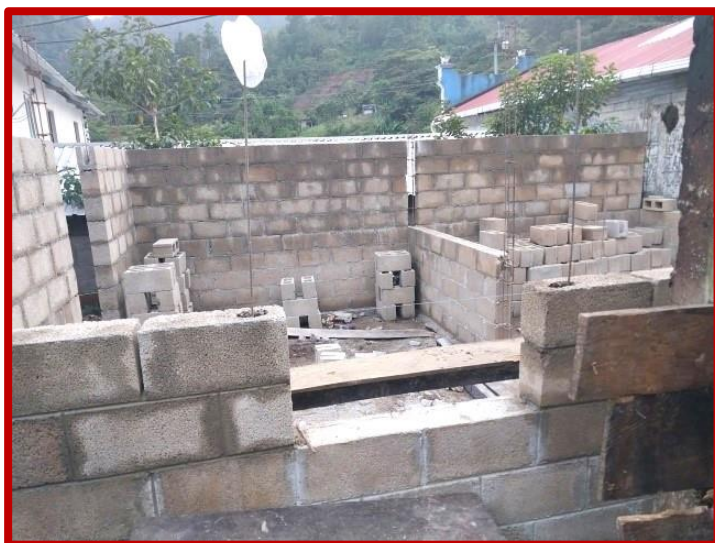
La vivienda de doña Micaela, a punto de cubrir aguas
